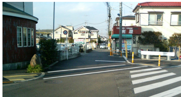
電柱を移設し、広くなった交差点
