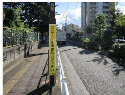
大山小西側道路の看板設置
