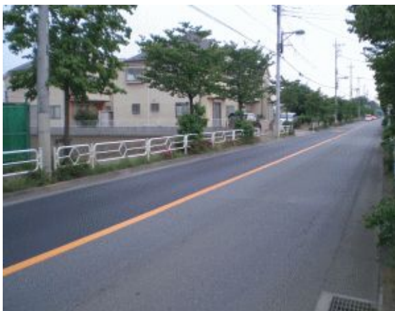
平成新道の道路補修
