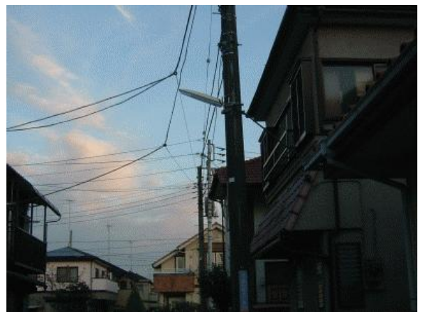
街路灯の設置
